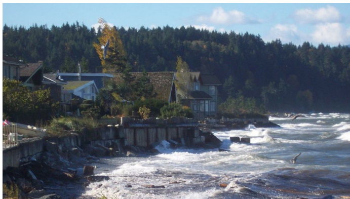
Figure 1.5.4. La compatibilité des méthodes naturelles est limitée par le taux d'énergie houleuse et la proximité des bâtiments avec le littoral. Crédit : Kelly Loch.
