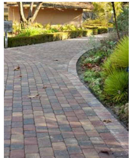
Figure 3.2.2. Revêtements perméables. Crédit : belgardhardscapes.files.wordpress.com .
