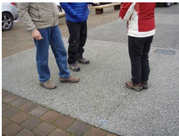
Figure 3.2.3. Zone de stationnement perméable. Crédit : H. Rueggeberg.
