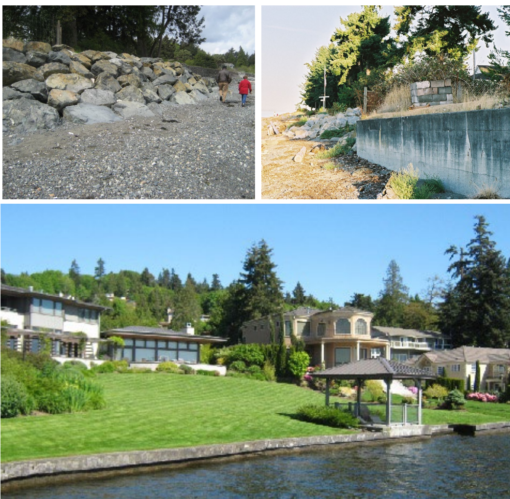
Figure 1.3.1. Exemples de protections en dur. Crédit : The Watershed Company, H. Rueggeberg.
