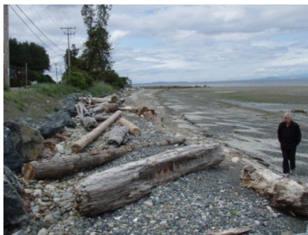
Figure 2.5.2. Matière ligneuse grossière ajoutée dans le cadre d'un traitement mou du littoral. Crédit : H. Rueggeberg.
