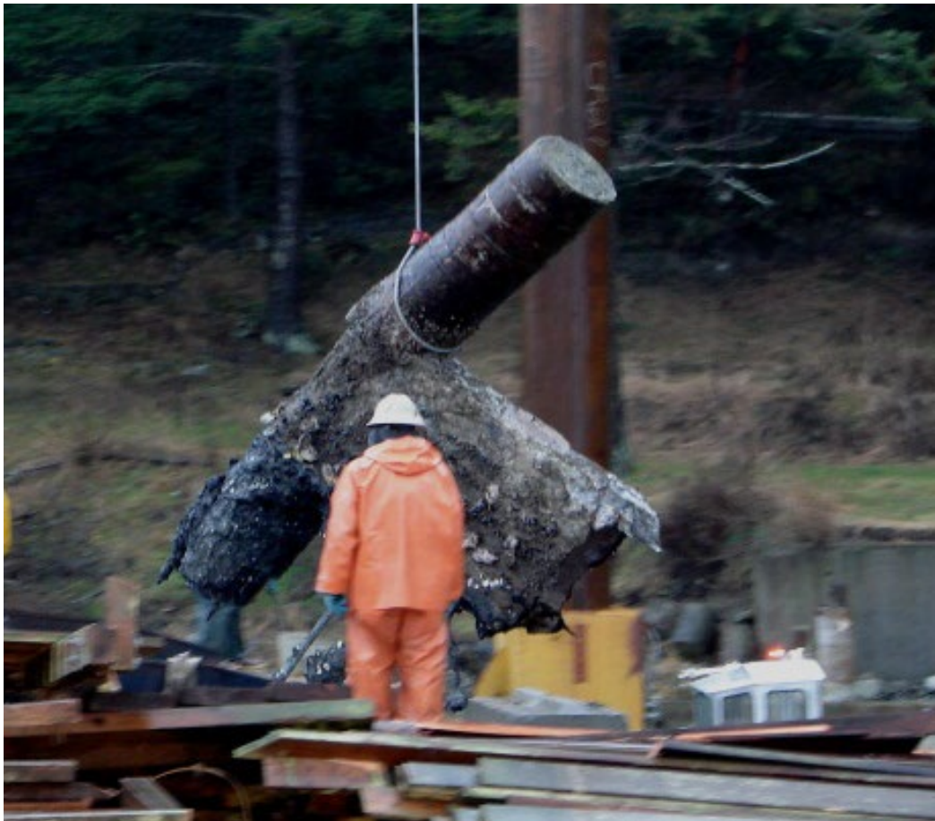
Figure 3.4.1. Enlèvement de matériaux contenant de la créosote. Crédit : Washington State Department of Natural Resources.
