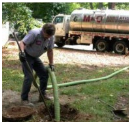
Figure 3.6.1. Pompage d'un système septique.
